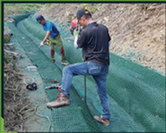
5. CIVIL ANCHOR 및 착지핀 설치
